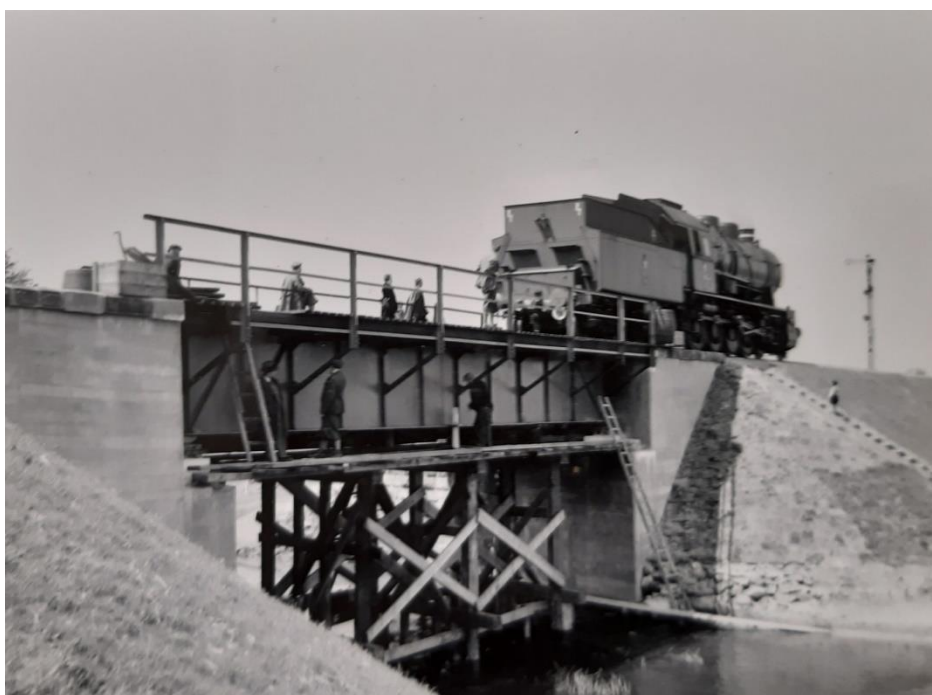
Most kolejowy na bocznicę prowadzącej do TFSJ. Fotografia wykonana podczas pomiarów obciążenia mostu przed dopuszczeniem go do użytkowania. Zbiory APTM.
