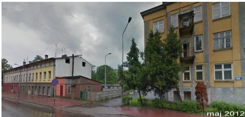
Fragment prawej strony ul. Spalskiej z widokiem na ścianę szczytową bloku mieszkalnego nr 114, dalej drewniany barak sklepu pod wierzbą u Chojnackich i jednopiętrowy budynek o nr 116/118. Fotografia autorstwa J. Gołębiewskiego.
