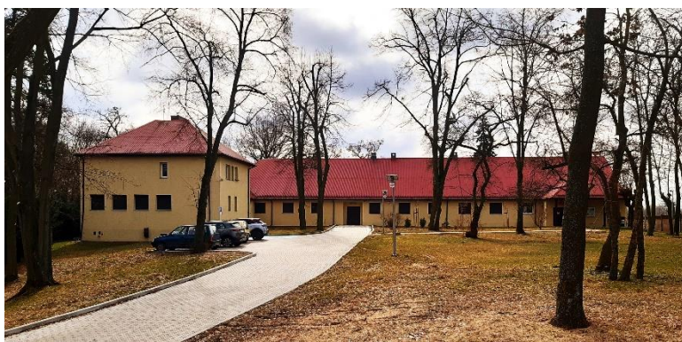
Następna posesja o nr 120 to jednopiętrowy a w głównej części parterowy budynek stojący w znacznym oddaleniu od ulicy, który został wybudowany w 1951 r. z przeznaczeniem na przedszkole. Obecnie jest on siedzibą miejscowego oddziału Archiwum Państwowego w
