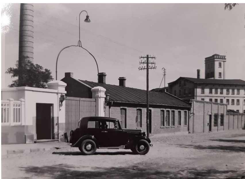
Główna portiernia, brama wjazdowa na teren TFSJ od strony ul. Spalskiej. Po prawej stronie placówka Urzędu Pocztowego, ceglany mur i fragment budynków starej fabryki Edwarda i Roberta Kleindiensta. Fotografia z lat 30. XX wieku. Zbiory APTM, TFSJ, sygn. 49/48/0/-/3144.
