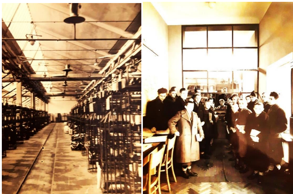
Powyżej hala skręcalni TFSJ i obok wypożyczalnia książek biblioteki TFSJ. Fotografia z lat 30. XX wieku. Zbiory APTM.
