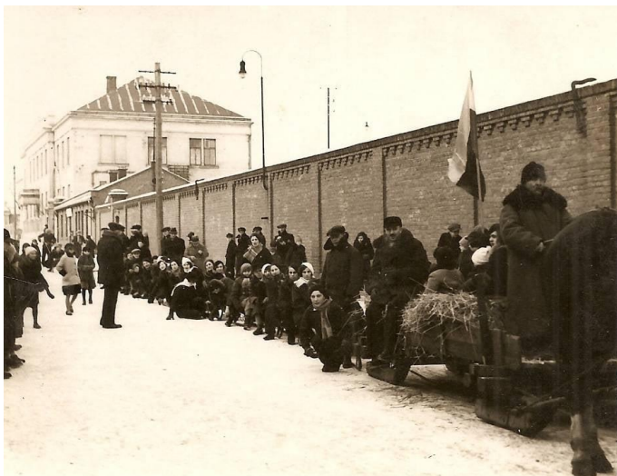
Ulica Spalska na wysokości biurowca i portierni. Fotografia z lat 30. XX wieku. Zbiory APTM.
