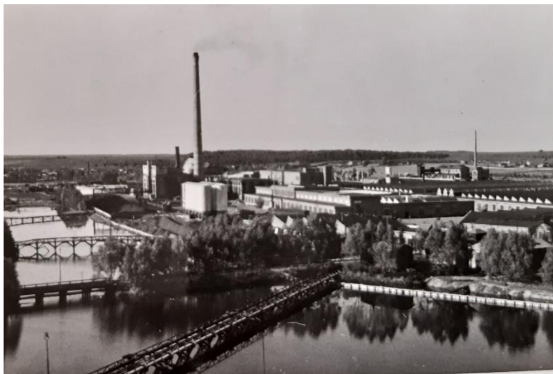
Widok na cztery z pięciu mostów łączących brzegi stawu. Po wschodniej stronie budynki oddziału skrucalni, przędzalni, blichowni, nowej kotłowni, centrali elektrycznej, nitracji, denitracji i warsztatu mechanicznego. Fotografia z 1936 r. Zbiory APTM.
