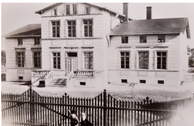
Widok na frontową elewację willi dyrektora M. Hertza w trakcie remontu. Na pierwszym planie metalowe ogrodzenie, które w późniejszym czasie zastąpiono podobnym, ale drewnianym. Fotografia wykonana około roku 1911-1912. Zbiory APTM, TFSJ, sygn. 49/48/0/-/3143.
