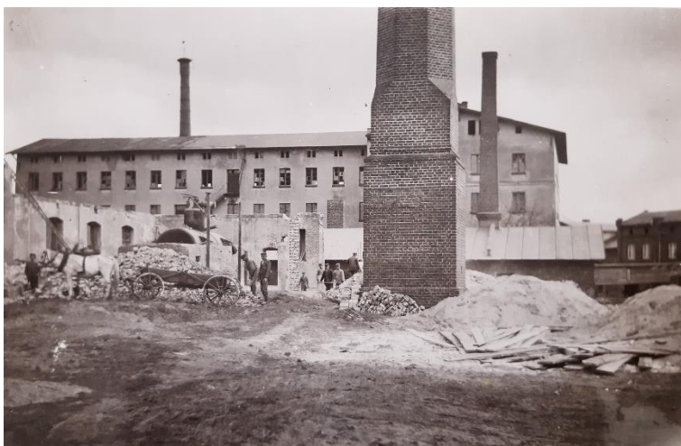
Budynek starej fabryki w trakcie robót remontowych oraz rozbiórka starej kotłowni. Fotografie z pierwszej połowy lat 20. XX wieku. Zbiory APTM, TFSJ, sygn. 49/48/0/-/3144.
