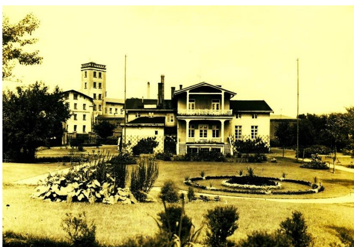
Budynek w roku 1910 został poddany gruntownej modernizacji, a rok później zasiedlony przez inż. M. Hertza, który nadzorował budowę TFSJ i był jej dyrektorem technicznym. Opis z lat 30. XX wieku wskazuje, że w budynku było 7 izb mieszkalnych. Na fotografii obok z roku 1922 willa widziana od strony ogrodu. Mieszkańcy to Michał i Eugenia z Hartmannów małżonkowie Hertz, ich córka Halina Maria i syn Jan Adolf. We wrześniu
